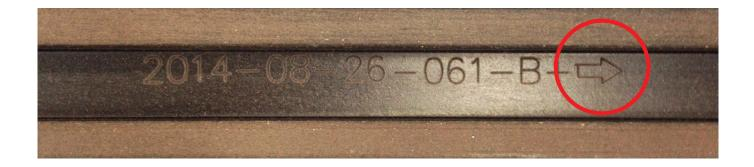
Bei der Verlegung sollte auf eine einheitliche Verlegerichtung geachtet werden. In den Nuten befinden sich entsprechende Markierungen.
